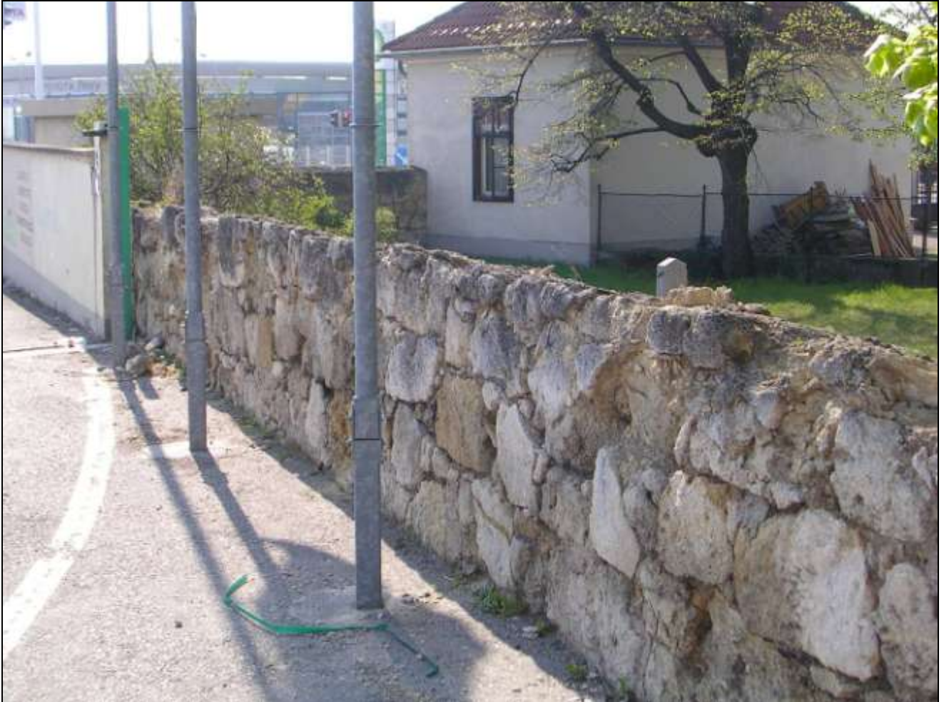
Bild 9: Nordmauer (außen) im Einfahrtsbereich (Blick nach O)
